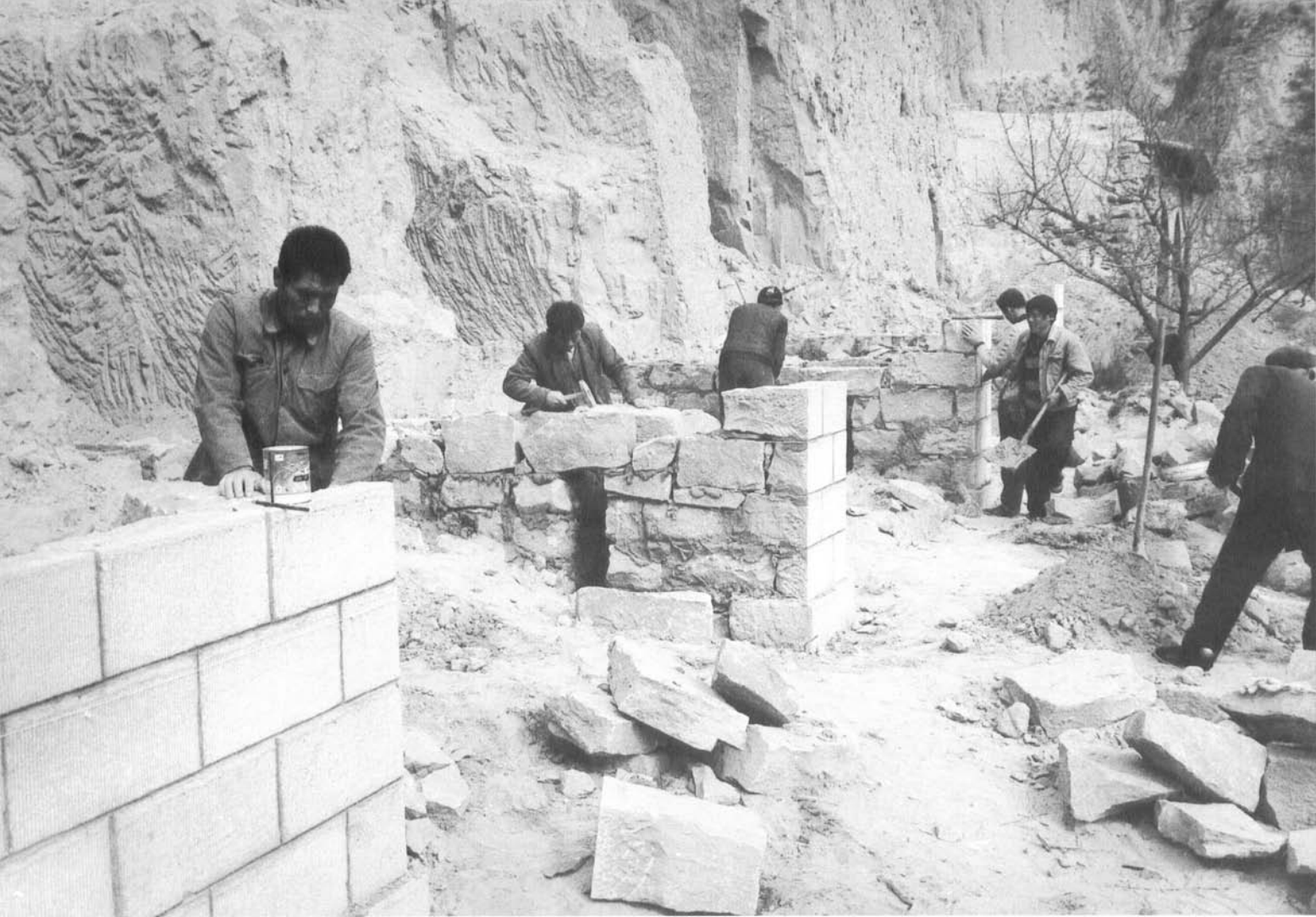
▲ 在地基上用石头砌起1.5米高的石头墙,也叫起腿子。
