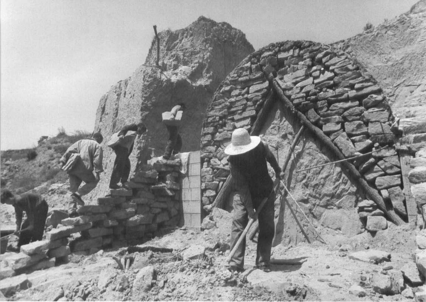
▲ 窑洞将来插好后，就要拆除木椽等支撑物，窑内土坯子也叫磁土，待合龙口之后，主人再慢慢倒出。
